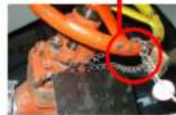
原子炉圧力容器ドレンライン 【CUW RPV 第一ドレン弁 (G31-F503X)】
