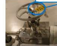
1次冷却材ループドレンライン 【3-Cループドレン弁 (3V-RC-020C)】
