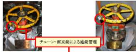
原子炉再循環系ドレンライン 【原子炉再循環ポンプ(A) 入口管第一ドレン弁 (B32- F503AX)】
