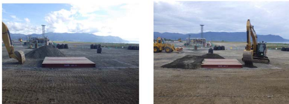
第10図 段差復旧状況
