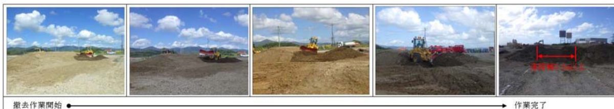
第5図 土砂撤去状況写真
