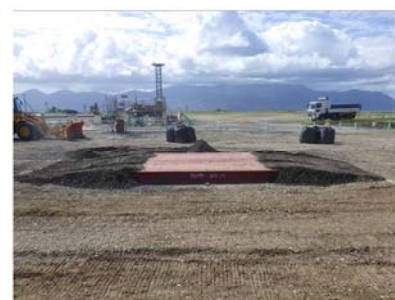
検証ヤード（復旧後）
