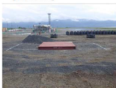
検証ヤード（復旧前）
