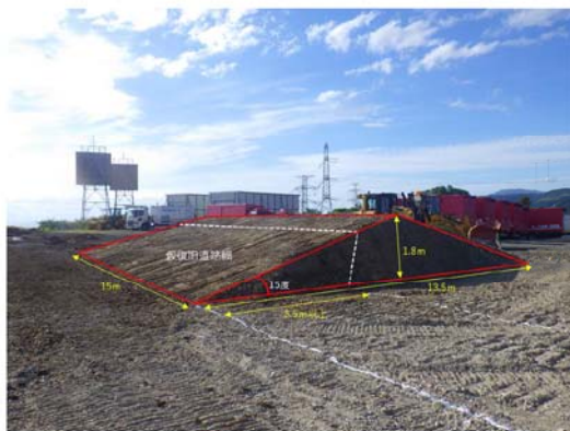
第3図 斜面崩壊後を模擬した土砂
