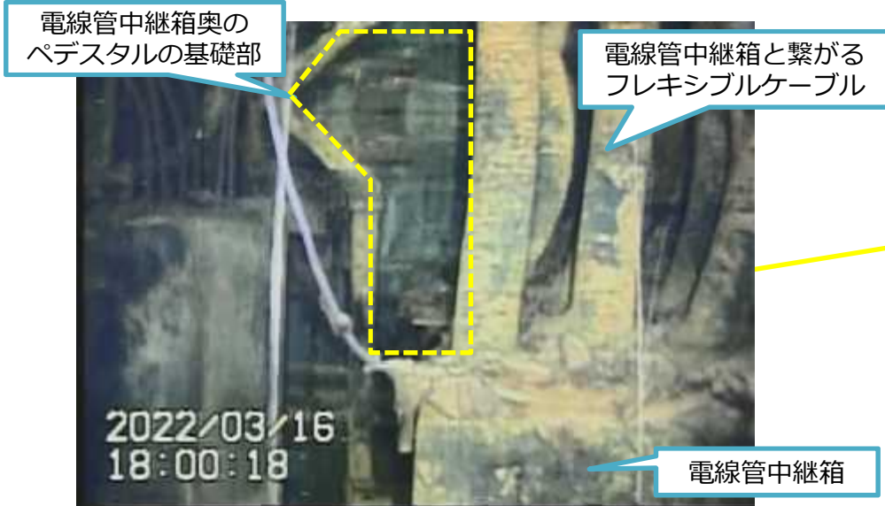
写真1.ペDESTAL基礎部付近の状況①
