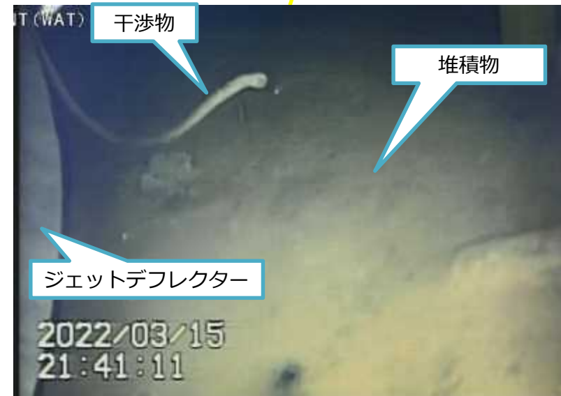
写真3. ジェットデフレクター(G)底部付近の状況②
