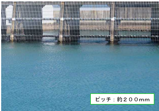
②取水口スクリーン ピッチ：約200mm
