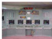
通常点灯時 (非常用照明及び既設照明兼非常用照明)
