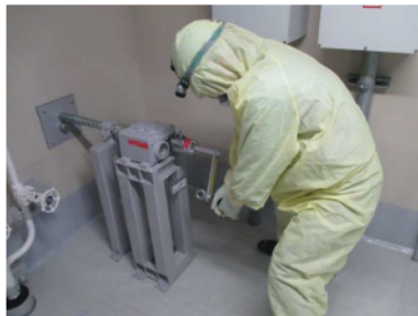
アニュラス排気ダンパ現場手動操作 (原子炉補助建屋 T.P. 40.3m)
