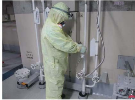
(制御用空気供給弁閉操作イメージ)
