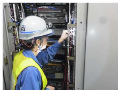
可搬型計測器の接続 原子炉補助建屋（T.P. 17.8m）
