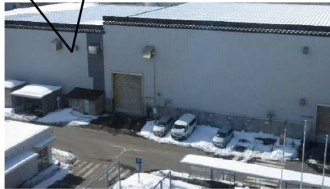
図1 建屋内風速の測定例（3号機給排水処理建屋）
