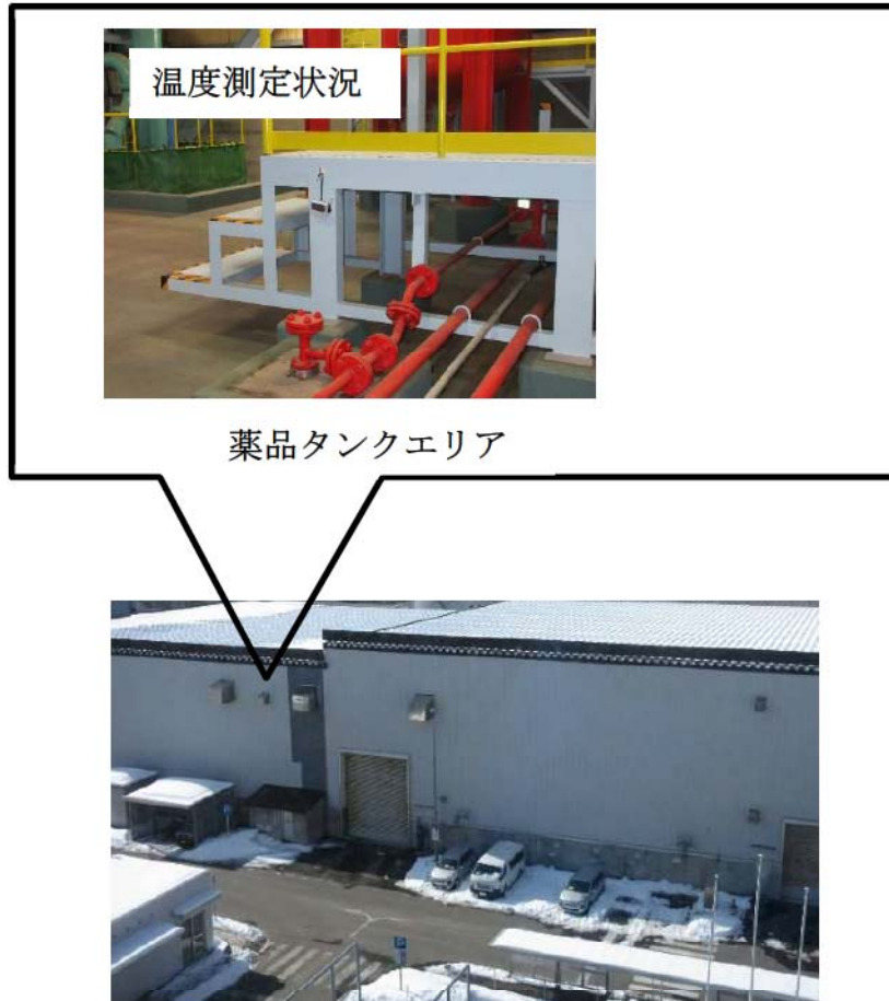
図2 建屋内温度の測定状況（3号機給排水処理建屋）
