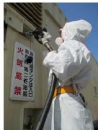
可搬型代替電源車の給油口に 給油ガン接続 (可搬型代替電源車) (屋外 T.P. 31m)
