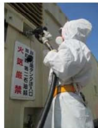
可搬型代替電源車の給油口に 給油ガン接続 (可搬型代替電源車) (屋外 T.P. 31m)
