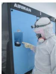
可搬型直流電源用発電機 給油口 (可搬型直流電源用発電機) (屋外 T.P. 31m)
