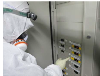
不要直流負荷の切離し操作 (安全補機開閉器室) (原子炉補助建屋 T.P. 10.3m)
