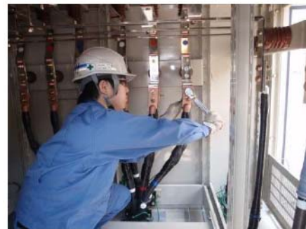
号機間連絡ケーブル接続 （屋外T. P. 31m）
