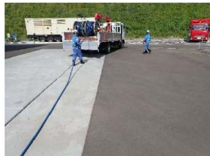
予備ケーブル敷設 (屋外T.P. 31m)
