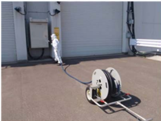
高圧ケーブル敷設 (屋外T. P. 31m)
