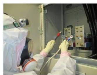
可搬型直流変換器 直流出力ケーブル接続作業 (安全補機開閉器室) (原子炉補助建屋 T.P. 10. 3m)
