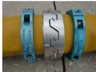
可搬型ホース(150A)接続後
