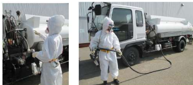
可搬型タンクローリー給油用ホース引出し (屋外 T.P. 31m)
