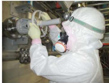
海から補助給水ピットへの補給 系統構成 (原子炉建屋 T.P. 17.8m)
