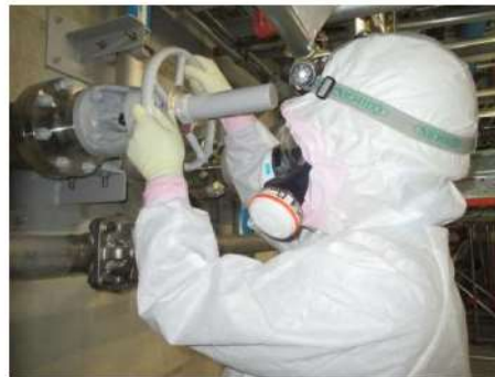
原水槽から補助給水ピットへの補給 系統構成 (原子炉建屋 T.P. 17.8m)
