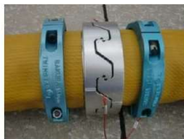
可搬型ホース(150A)接続後
