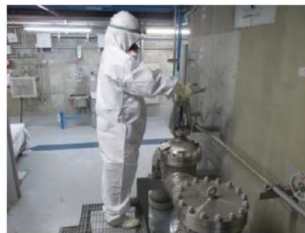
補助給水ピット水源切替 系統構成 (原子炉建屋 T. P. 10. 3m)
