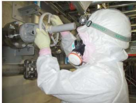
代替給水ピットから 補助給水ピットへの補給系統構成 (原子炉建屋 T.P. 17.8m)
