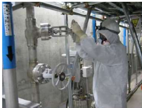
補助給水ピット供給 ライン系統構成 (原子炉建屋 T.P. 24.8m)
