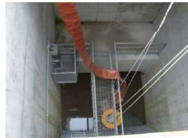
海水取水箇所への水中ポンプ設置 (屋外 T. P. 10m)
