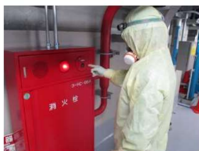
消火ポンプ起動 (原子炉建屋 T.P. 40.3m)
