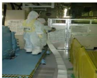
可搬型ホース敷設 (燃料取扱棟 T. P. 33. 1m)
