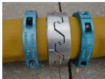
可搬型ホース (150A) 接続後
