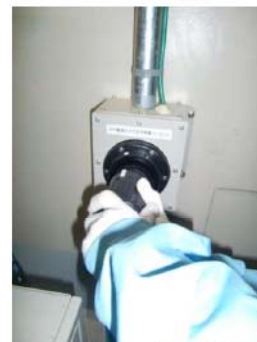
電源ケーブル接続
