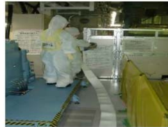
可搬型ホース敷設 (燃料取扱棟 T. P. 33. 1m)
