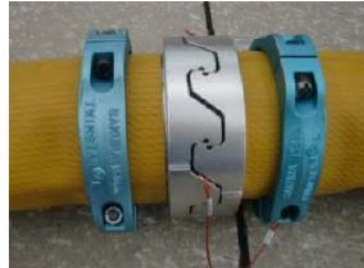
可搬型ホース (150A) 接続後
