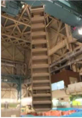
ゲート吊上げ作業 (写真は2号機)
