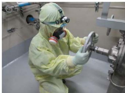
1次系補給水ポンプによる 注水系統構成 (原子炉補助建屋 T.P. 17.8m)
