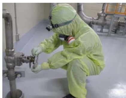
2次系補給水ポンプによる注水 (原子炉建屋 T.P. 10. 3m)
