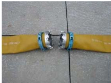
可搬型ホース (150A) 接続口
