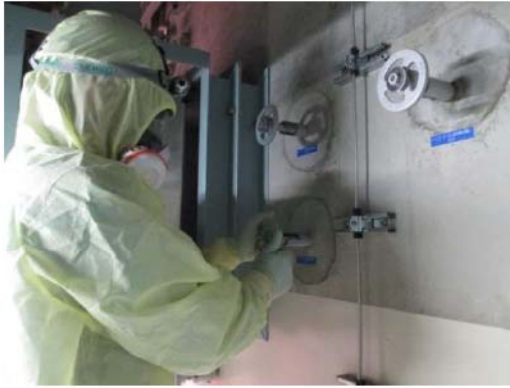
原子炉格納容器水素濃度監視系統構成 (原子炉建屋 T.P. 28.0m)
