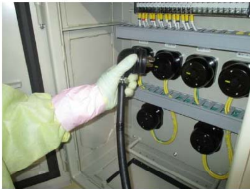
原子炉格納容器水素濃度監視電源操作 (原子炉建屋 T.P. 24.8m)
