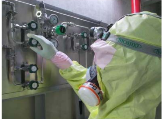
代替空気(窒素)供給操作 (原子炉建屋 T.P. 24.8m)
