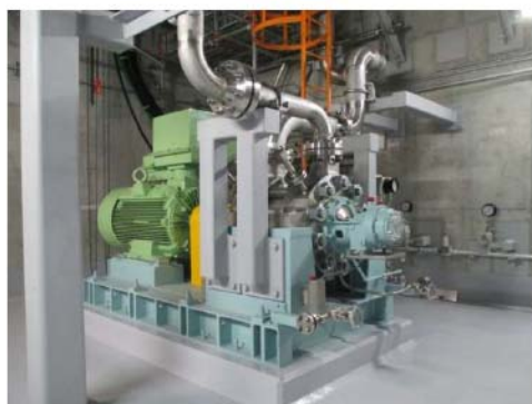
代替格納容器スプレイポンプ （原子炉建屋 T. P. 10. 3m）
