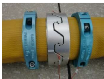
可搬型ホース(150A)接続後
