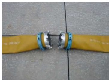
可搬型ホース(150A)接続口
