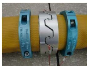
可搬型ホース (150A) 接続後
