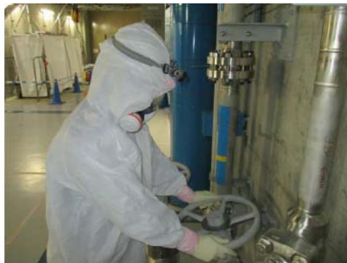
炉心注水から格納容器スプレイへの切り替え 系統構成 (原子炉建屋 T. P. 10. 3m)
