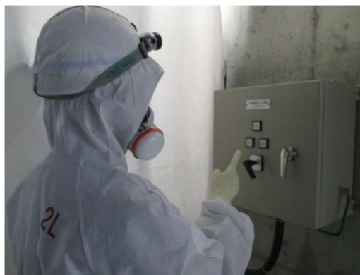
代替格納容器スプレイポンプ起動操作 （原子炉建屋 T.P. 10. 3m）
