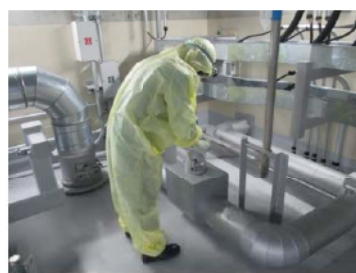
原子炉への注水ライン 系統構成 (運転員（現場）①) (原子炉補助建屋 T.P. 14.5m)
