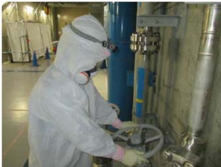
格納容器スプレイから炉心注水への切り替え 系統構成 (原子炉建屋 T.P. 10.3m)
