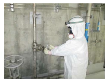
原子炉への注水ライン 系統構成 (運転員（現場）②) (原子炉建屋 T.P. 10.3m)
