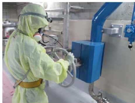
充てんポンプ自己冷却運転系統構成 (原子炉補助建屋 T.P. 14.5m)
