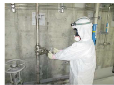
原子炉への注水ライン 系統構成 (運転員（現場）②) (原子炉建屋 T.P. 10.3m)
