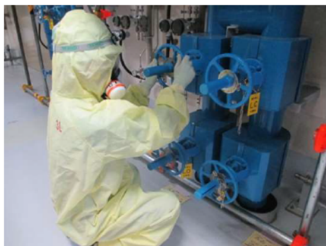
充てんポンプ自己冷却運転系統構成 (原子炉補助建屋 T.P. 10.3m)
