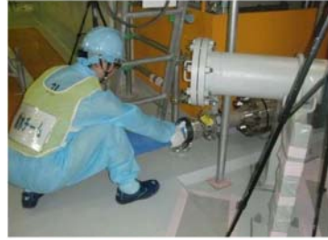
可搬型ホース敷設 (原子炉建屋 T. P. 24. 8m)
