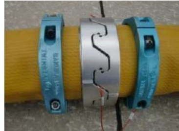
可搬型ホース (150A) 接続後
