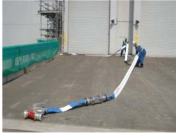
可搬型ホース運搬 (屋外 T. P. 31m)
