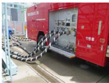
可搬型大型送水ポンプ車の設置 ポンプ車周辺のホース敷設 (屋外 T. P. 10m)
