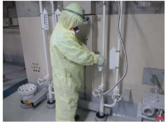
(制御用空気供給弁閉操作イメージ)
