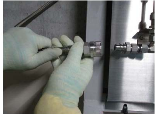
アニュラス全量排気弁操作用可搬型 窒素ガスポンペのカップラ接続 (原子炉補助建屋 T.P. 40. 3m)
