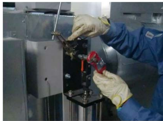
(空気作動ダンパ開作業イメージ)
