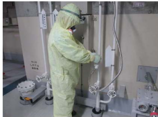
(制御用空気供給弁閉操作イメージ)
