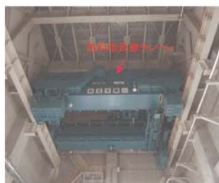
④燃料取扱棟クレーン
