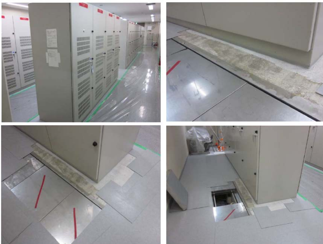
参考資料 1 添付 2-図 2 電気盤とフロアケーブルトレイとの位置関係
