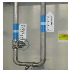
出入管理建屋 T. P. 6. 3m 洗濯設備室
