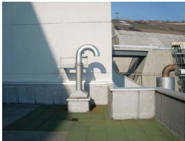
図1 タービン動補助給水ポンプ排気管の設置状況
