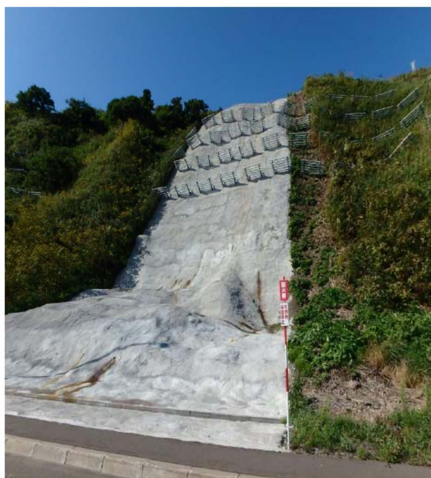
図1 防火帯モルタル吹付工の施工例
