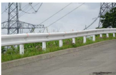
ガードレール
