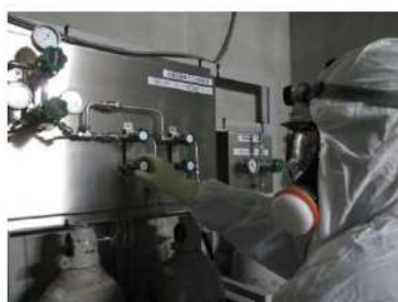
原子炉補機冷却水サージタンク加圧操作(タイベック+全面マスク)
