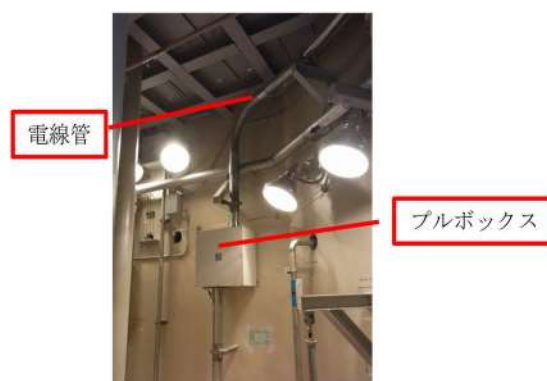
図－5 核計装電線管布設状況
