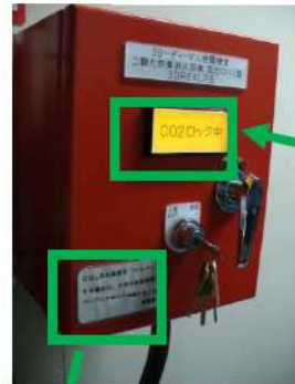
写真③ 放出ロック盤
