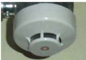
光電アナログ式スポット型煙感知器
