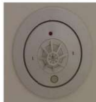
差動式スポット型熱感知器
