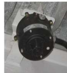
定温式スポット型熱感知器 (防爆型)
