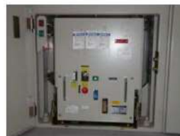
原子炉トリップ遮断器
