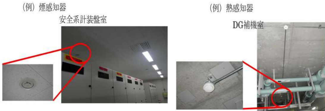
図-8 煙感知器、熱感知器設置例
