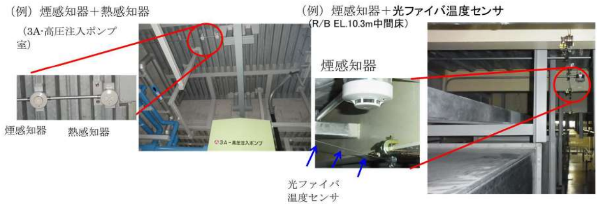
図-9 煙感知器、熱感知器、光ファイバ温度センサ設置例
