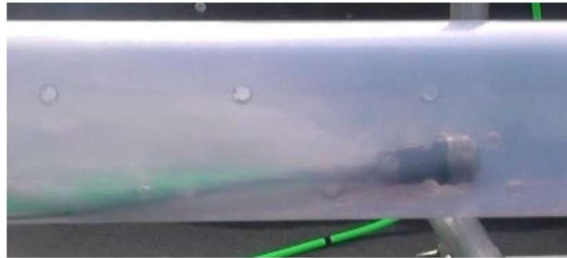
添付6-3(4) 図 管内清掃装置進行時の様子
