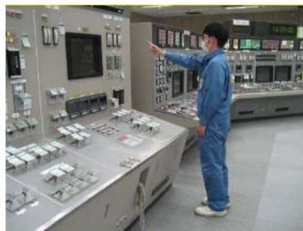
アナログ型の中央制御盤（泊1／2号炉）
