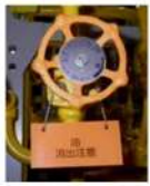
油類に係る弁 弁の識別
