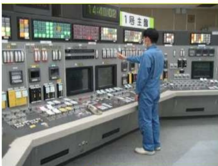
アナログ型の中央制御盤（泊1／2号炉）
