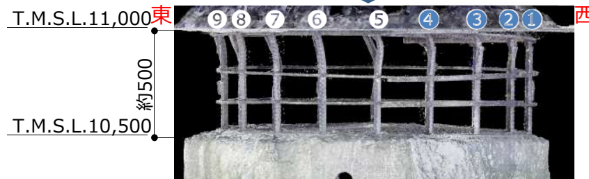
図11 No.8杭頭部の鉄筋の損傷状況 (単位: mm)
