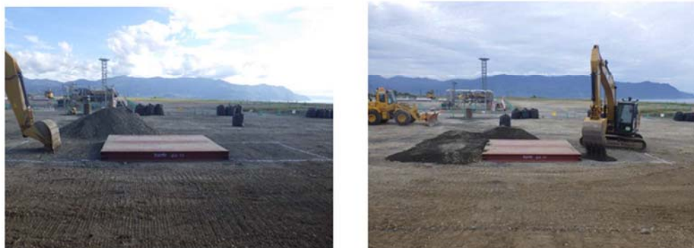
第10図 段差復旧状況
