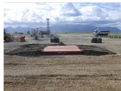
検証ヤード（復旧後）
