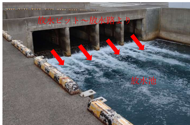
図1 1，2号機放水池（循環水ポンプ停止状態）
