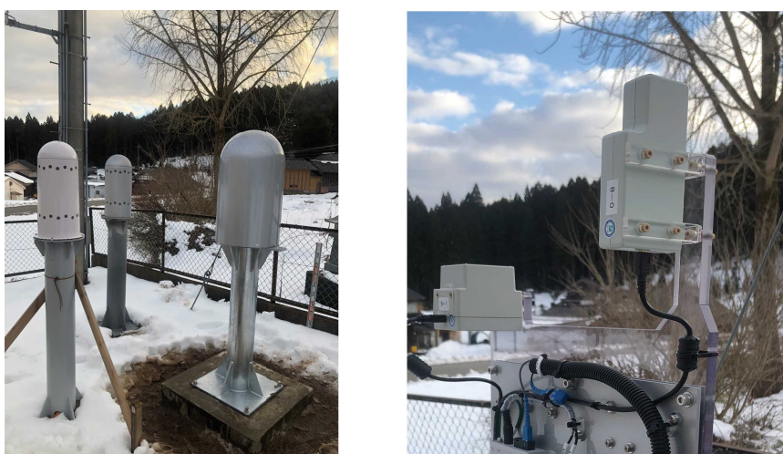
図 31 石川県に設置された C12137-06HA。既設モニタリングポスト（志賀町赤住局）に隣接する形で、従来のモニタリングポストと類似の形状の樹脂製容器に入れて設置されている（左）。検出器は高計数率対応版の C12137-01 と共に設置されている。C12137-06HA の高さは 1.8 m である。
