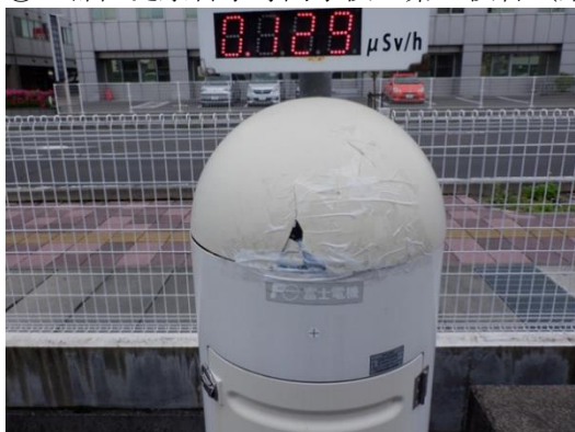
車の接触によりドーム部破損
