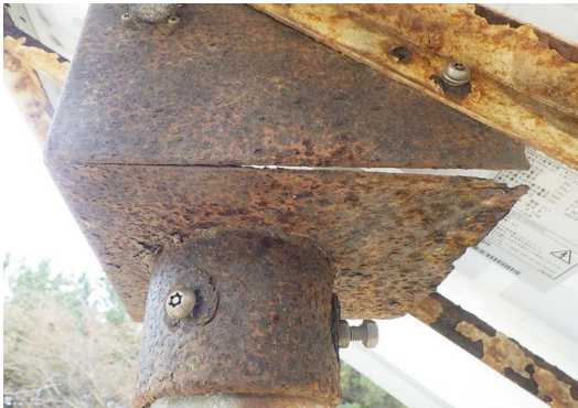
錆により太陽光パネル架台と表示器が腐食している
