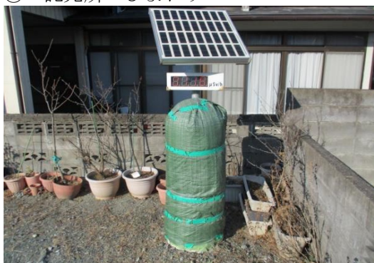
筐体部分が破損し養生していたポストを新しい筐体に交換
