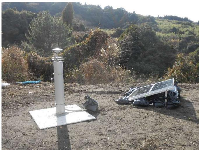
図 2-1-1-10 桜島北部の GNSS 新観測点の機器設置状況
