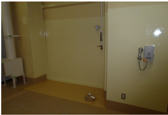
図 6.1.A2-19 作業終了後（壁）
