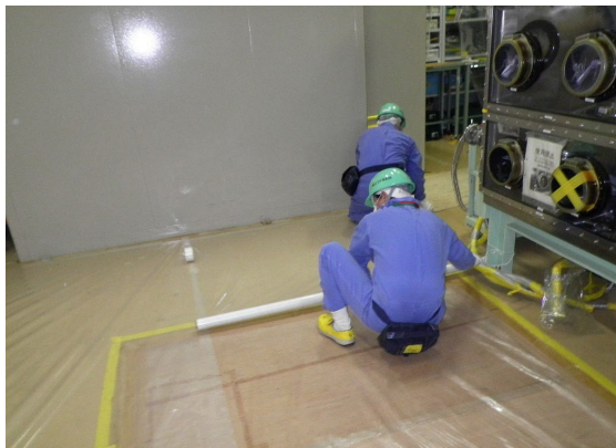
図 6.1.A2-5 作業エリア養生
