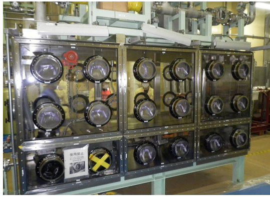
図 6.1.A2-1 撤去作業前（グローブボックス）
