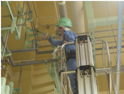
図 6.1.A2-13 高所作業（配管等の撤去）
