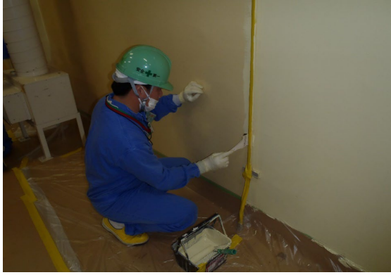
図 6.1.A2-17 撤去後補修（壁）
