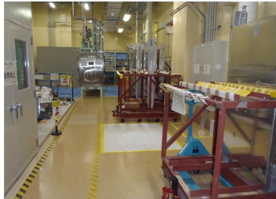
図 6.1.A2-4 撤去作業前（反射体）
