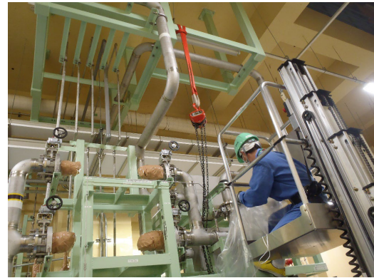
図 6.1.A2-12 給排気配管等の撤去
