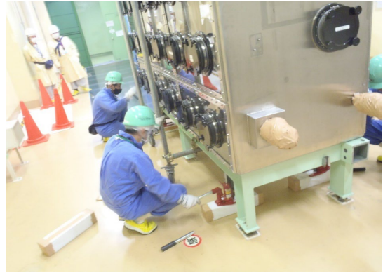
図 6.1.A2-10 グローブボックス撤去①
