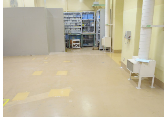
図 6.1.A2-20 作業終了後（全体）
