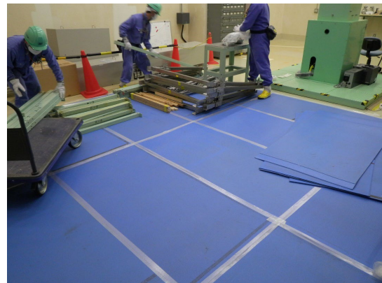
図 6.1.A2-6 撤去品置場の養生
