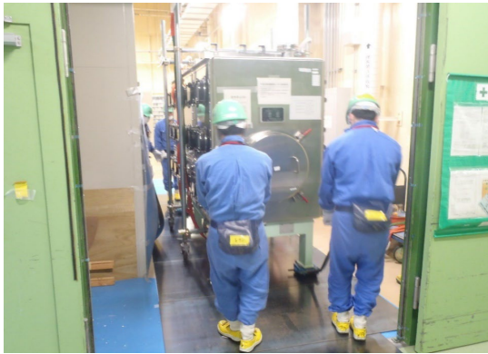
図 6.1.A2-11 グローブボックス撤去②
