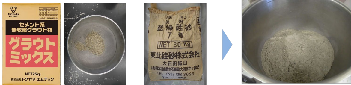
図 6.3-1 モルタルの調整
