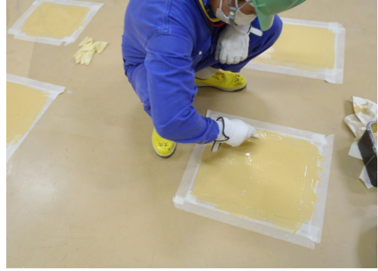
図 6.1.A2-18 撤去後補修（床）
