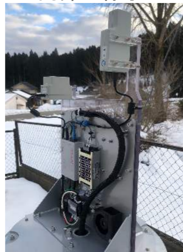
新設 モニタリングポスト 内部の様子
