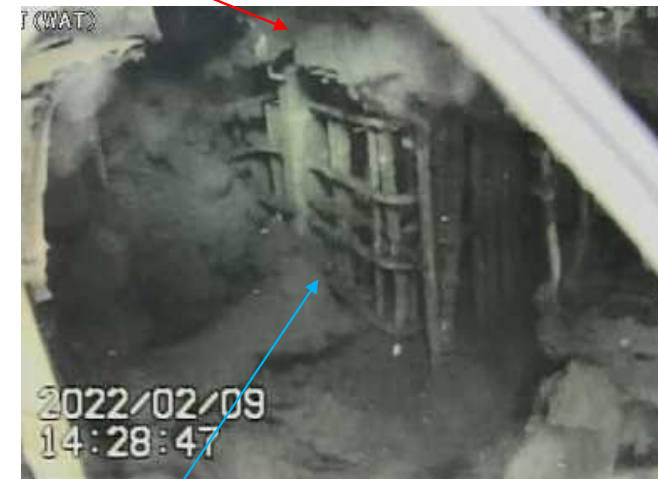
A. ペDESTAL開口部付近
