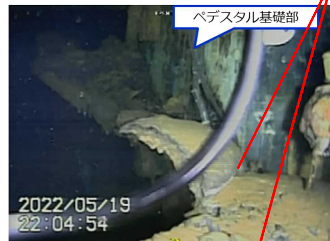
A. ペDESTAL開口部付近
