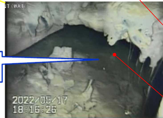
写真3.PCV底部の堆積物の状況(空洞内部)
