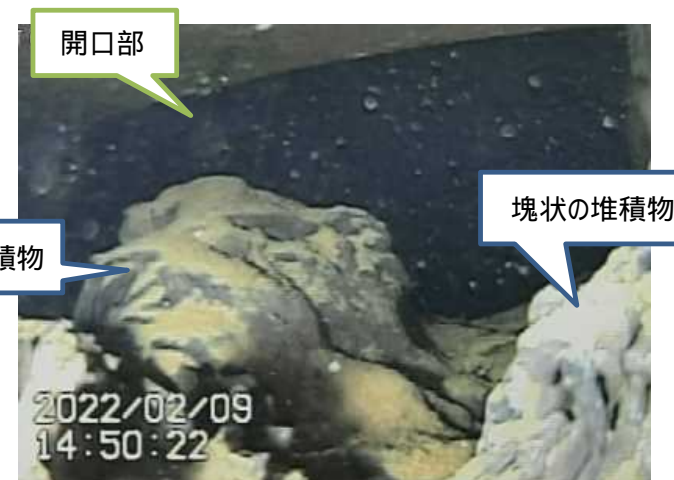
C . ペDESTAL開口部内部
