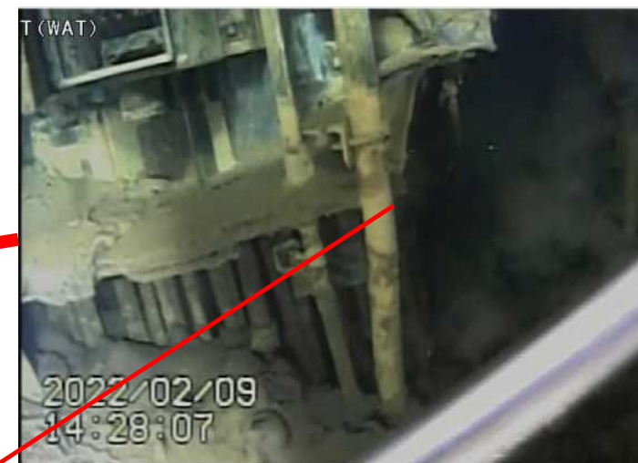
ペDESTAL開口部付近の状況(俯瞰)
