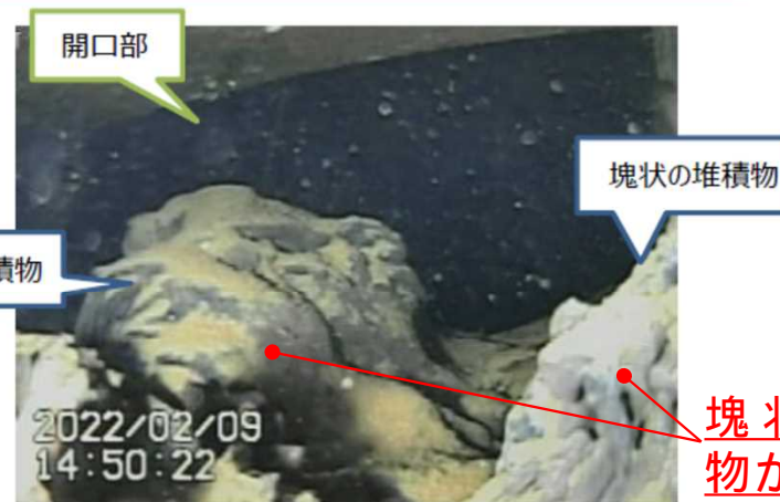
C. ペDESTAL開口部内部
