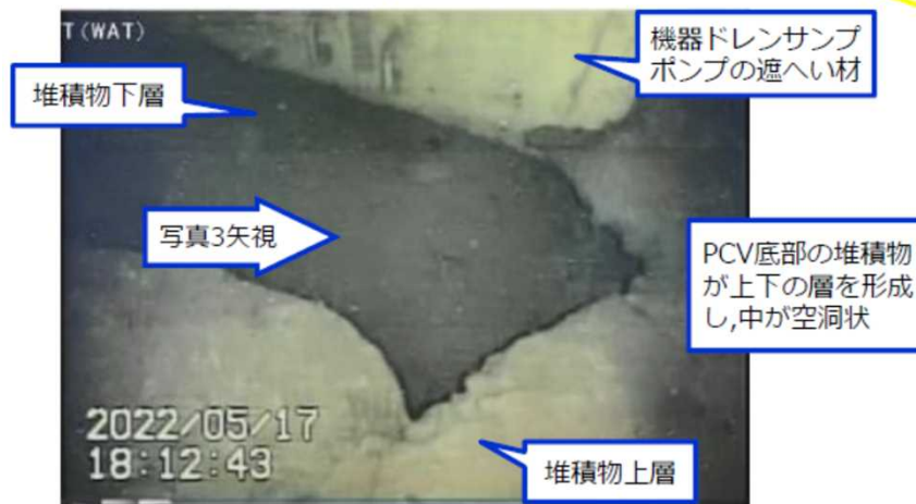
写真2.PCV底部の堆積物の状況
