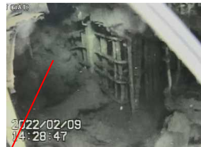
A . ペDESTAL開口部付近
