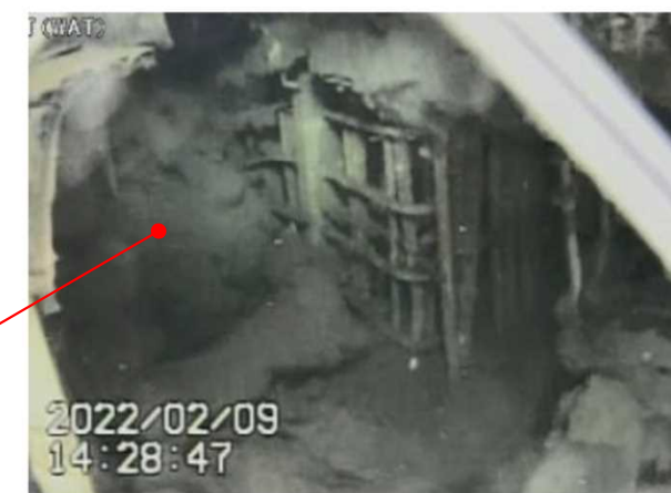
A. ペDESTAL開口部付近
