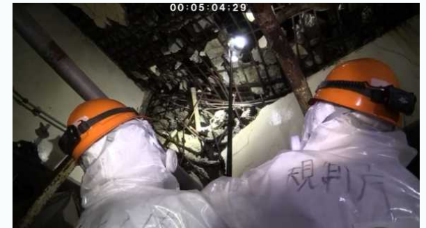
3号機原子炉建屋内調査(令和2年9月)
