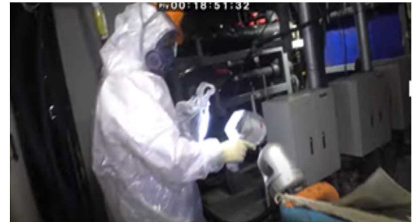
1号機原子炉建屋内調査(令和3年11月)
