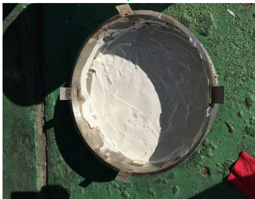
閉止キャップ内面への接着剤塗布後
