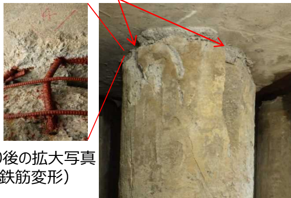
図28 No.8杭頭部の損傷状況
