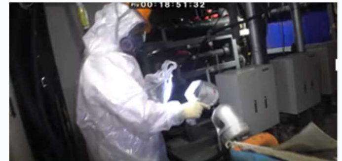
1号機原子炉建屋内調査(令和3年11月)
