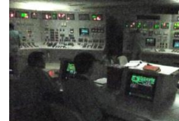
シミュレータ訓練 （全交流電源喪失対応）
