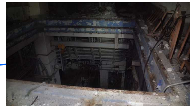
(大物搬入口付近の様子)
