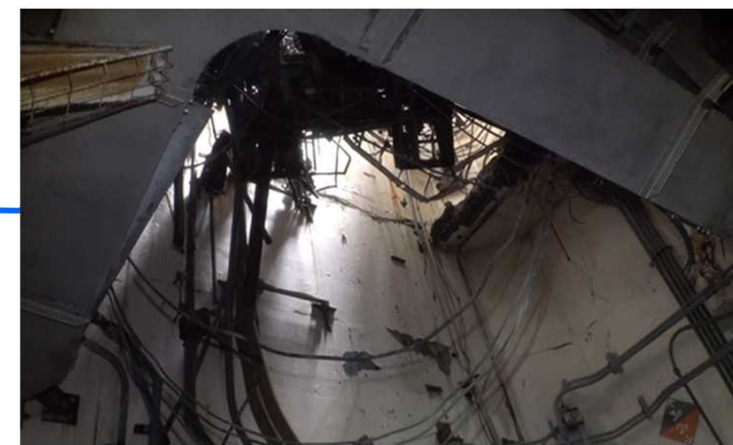
(北西側階段上の様子)
