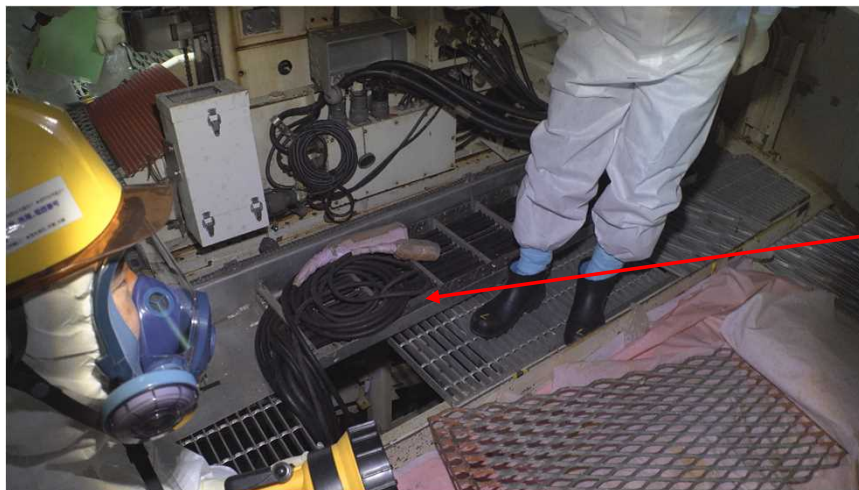
CRD交換機ケーブル(ペDESTAL内)
