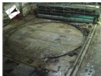
遮蔽設置前の状況
