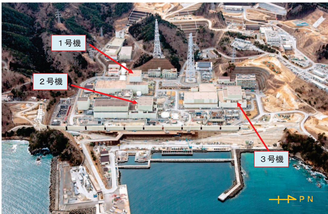
図 2-2 女川原子力発電所の全景
