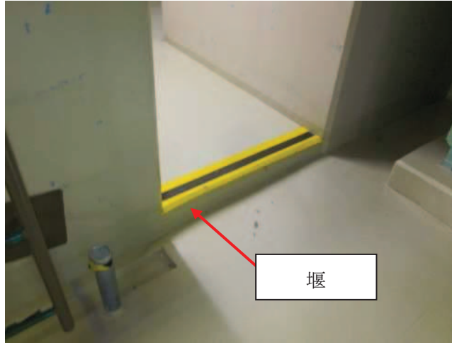
図 4-1 漏えい油の拡大防止対策の例
