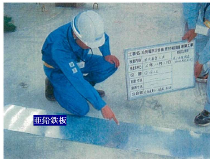
2-17図 集水管敷設状況写真(泊3号炉建設時)
